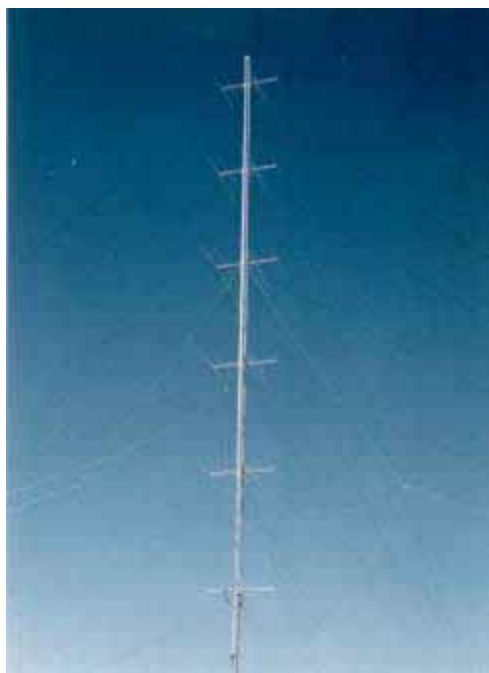
Zestaw sześciu anten Force 12 C-3 (od 30 do 180 stóp) na 190-stopowej obrotowej wieży u N7ML.
